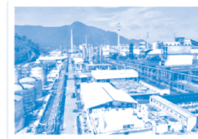
图：印尼金瑞新能源焦炭项目现场
