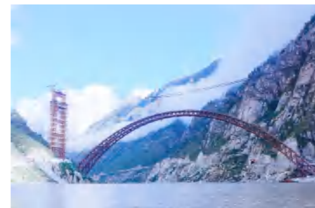
藏木特大桥是我国第一座真正意义上的免涂装耐候钢桥，其免涂装耐候钢板和耐候焊丝焊条用钢全部由南钢股份供应
